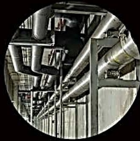
Topografía de túneles de servicios subterráneos
